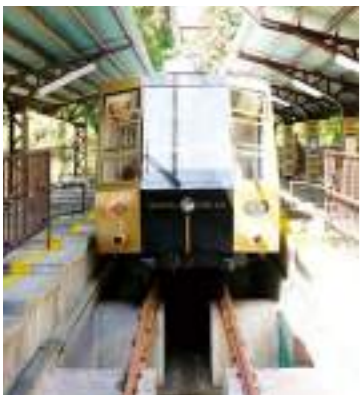
真正面からケーブルが見られるホーム
